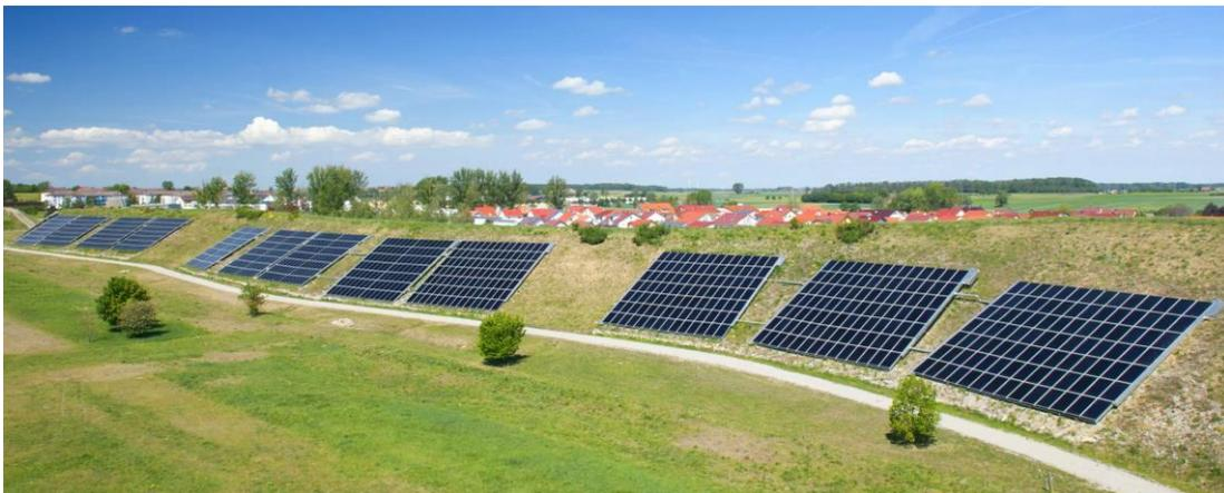
Abbildung 3-4 Freiflächen-Solarthermieanlage in Crailsheim [<https://www.stw-crailsheim.de/ueberuns/projekt-solarthermie/>]
