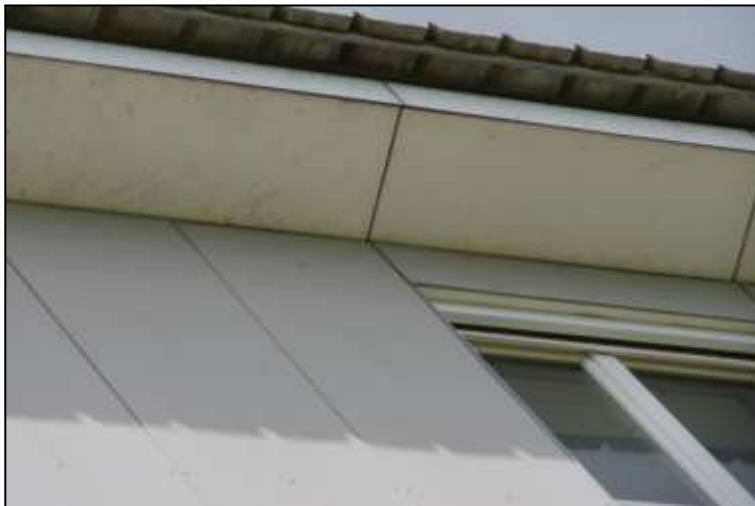
Abb.: Verblendung von OG und Dachüberstand
