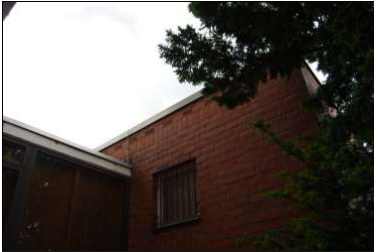
Abb.: Attika an Verbindungsbau und Nebengebäude
