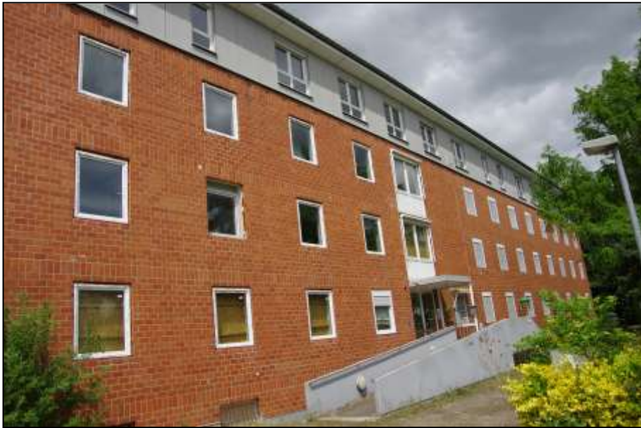
Abb.: Hauptgebäude, Ansicht Ost
