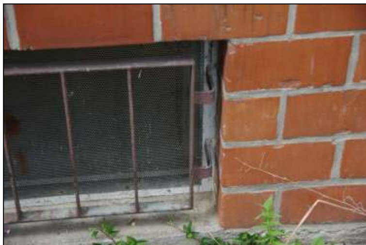
Abb.: Dicht verschlossene Kellerfenster
