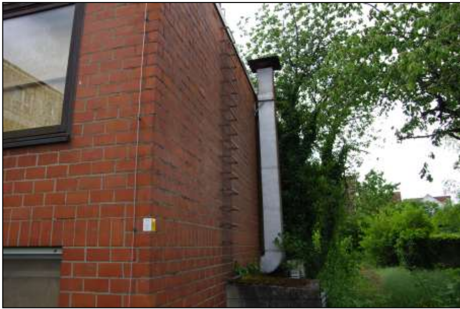
Abb.: Nebengebäude, Ansicht West
