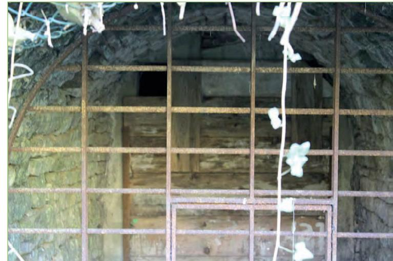
Abb. 2: Bretterschalung mit Einflugloch für Fledermäuse hinter Stahltor
